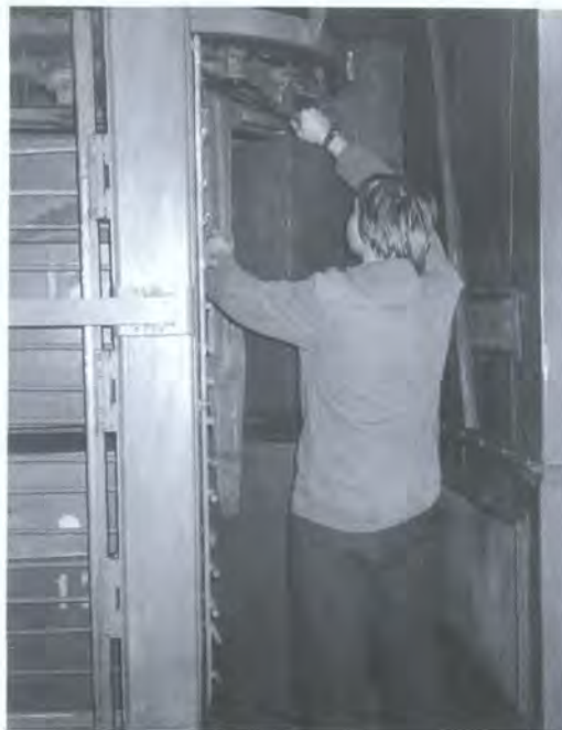
Системы обеспечения безопасности должны предупреждать аварийные ситуации, подобные этой, когда оператор пытался высвободить застрявшую в облучающей установке упаковку, в то время как источник излучения не был экранирован.
