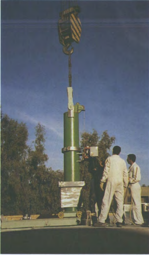
转移燃料行动的几个镜头：在 1993 年后期到 1994 年初的 5 个月里，IAEA 组织并监督了从伊拉克的图韦查核研究中心和附近的贮存地运走已申报的所有核武器级材料的工作。总计有 208 个乏燃料组件形式的高浓铀被回收、清洗、装入重量达 23 吨的运输容器、加封记并运出伊拉克。共有 170 名工作人员参加了这一行动，包括伊拉克的工作人员、IAEA 专家以及美国和俄罗斯的承包商。这里展示的是这项既复杂、技术要求又很高的行动的一些镜头。（来源：R. Ouvrard, IAEA；伊拉克原子能委员会）
