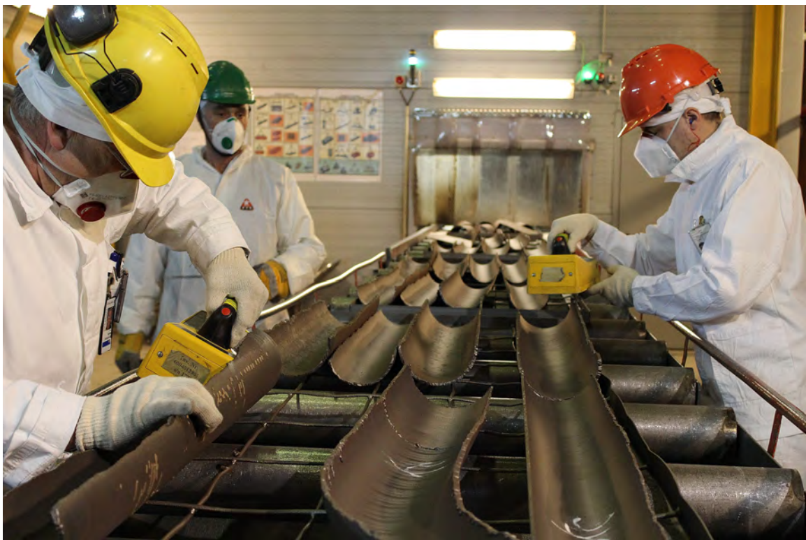
图 2. 工人们拆除伊格纳林纳核电厂汽轮机大厅，测量废金属查找辐射痕迹（档案照片）。
