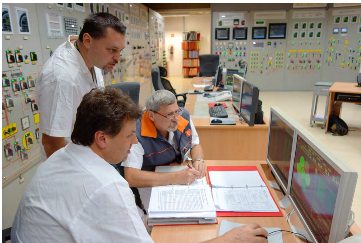
图 2. 杜科瓦尼核电厂的电厂控制室（档案照片）。
