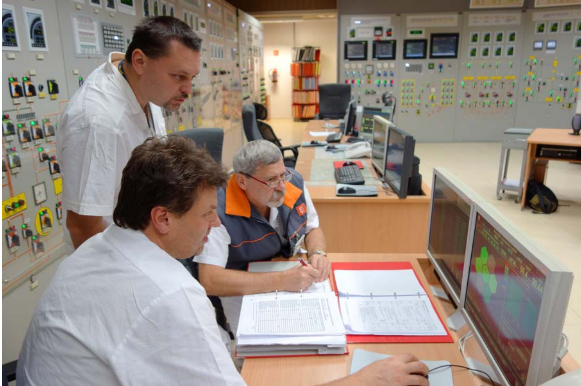
الشكل ٢ - صورة ملتقطة من داخل غرفة التحكم في محطة القوى، محطة دوكوفاني للقوى النووية (صورة أرشيفية).
