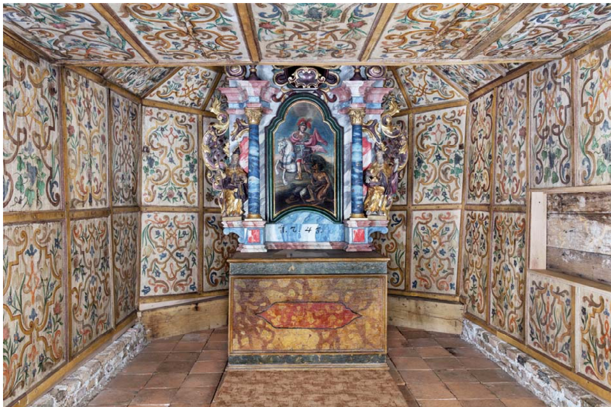
FIG. 2. Vue de la chapelle Saint Martin, à Stari Brod (Croatie), après sa conservation et restauration par radiotraitement. (Photographie issue des archives de l'Institut de restauration croate et reproduite avec la permission de ce dernier.)
