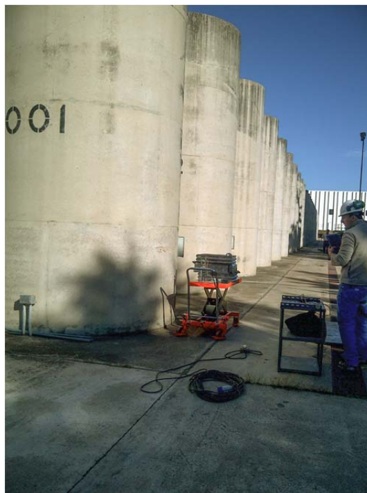
РИС. 2. Эксперты проверяют целостность хранилища отработавшего топлива и структурную целостность железобетонного бункера в сухом хранилище на АЭС «Эмбальсе», Аргентина, – пример исследований характеристик отработавшего ядерного топлива и элементов сопутствующей системы хранения, осуществляемых при поддержке Агентства на основе ПКИ. (Фотография предоставлена НКАЭ/«Нуклеоэлектрика Аргентина»).
