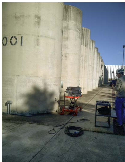
FIG. 2. Experts vérifiant l'intégrité du confinement du combustible usé et l'intégrité structurale des silos d'entreposage à sec en béton armé de la centrale nucléaire d'Embalse, en Argentine, exemple de travaux de recherche sur la performance de l'entreposage à très longue durée du combustible nucléaire usé et sur les composants des systèmes d'entreposage connexes appuyés par des PRC de l'Agence. (Crédit photo : CNEA/NASA)
