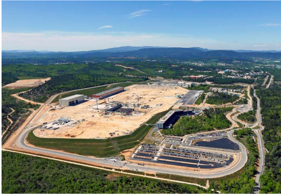
FIG. 4. Vue aérienne de la plateforme de 42 hectares d'ITER, fin 2014, montrant des progrès notables dans la construction des bâtiments de bureaux et des bâtiments techniques. (Crédit photo : ITER)
