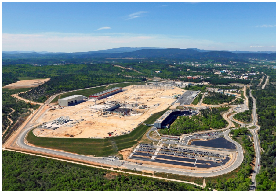
图 4. 2014 年底 42 公顷国际热核实验堆平台的俯视图，可见办公大楼和功能建筑的建造进展（照片由国际热核实验堆提供）。
