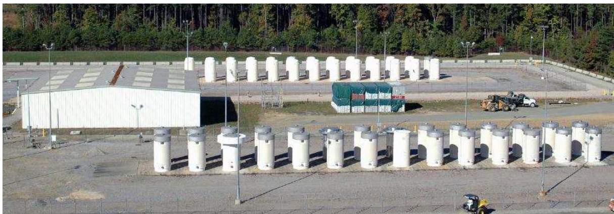
FIG. 4. Installation indépendante d'entreposage de combustible usé à la centrale nucléaire de Surry, Virginie (États-Unis d'Amérique), une unité d'entreposage à sec de combustible usé en châteaux sur le site du réacteur.
