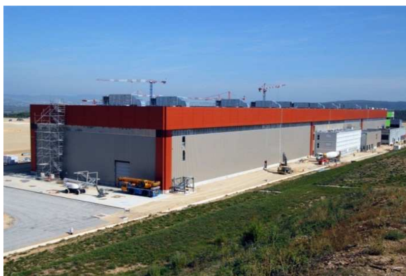
FIG. 6. Hall des bobines de champ poloïdal, premier bâtiment achevé pour l'ITER.
