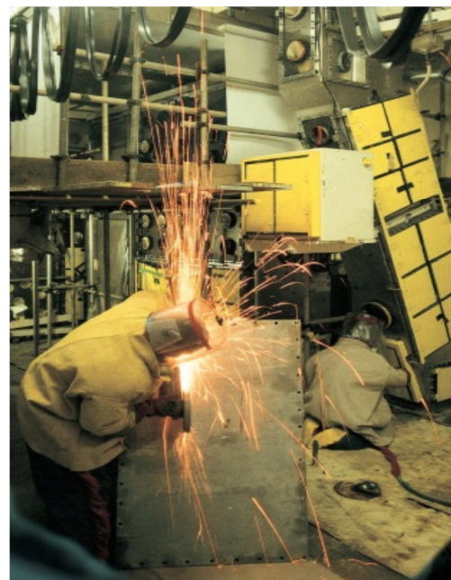
FIG. 1. Déclassement d'une boîte à gants dans une installation de fabrication de combustible.
