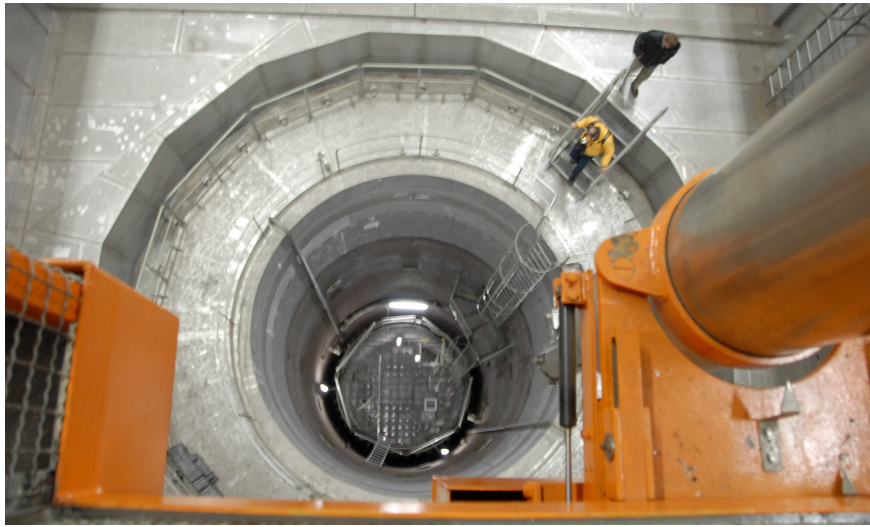
الشكل ٦ - مفتشون يتحققون من السمات التصميمية لقلب مفاعل نووي فارغ.
