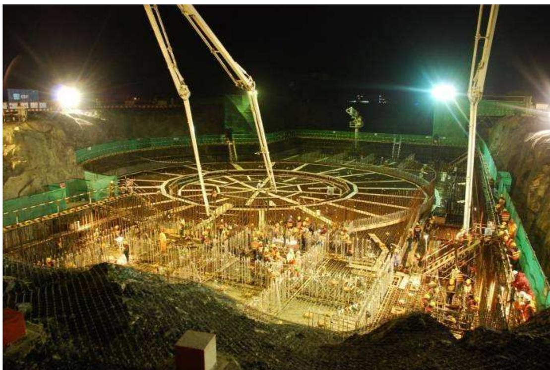
*РИС. 1. Ядерно-энергетический проект "Саньмынь" в Китае - заливка первого бетона.*
