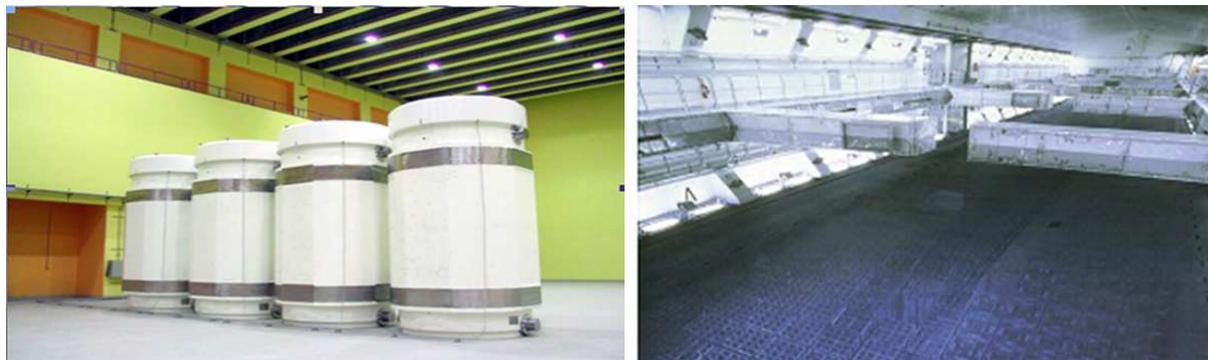
РИС. 2. Установки для сухого (слева) и мокрого (справа) хранения топлива.
