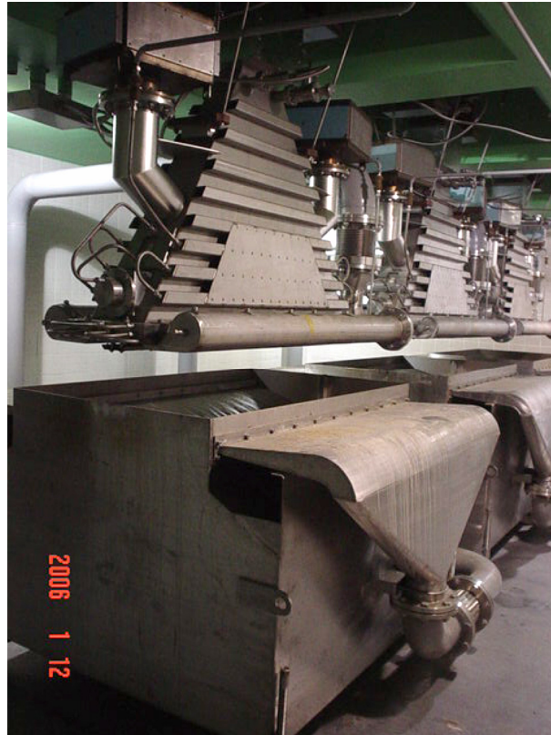
الشكل ١- أول محطة عاملة لمعالجة مياه الفضلات باستخدام الحزم الإشعاعية الإلكترونية على نطاق صناعي في جمهورية كوريا.
