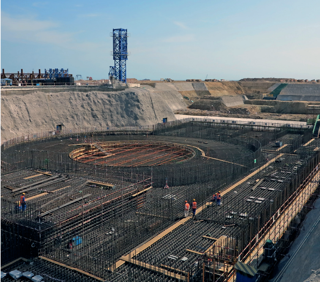
Centrale nucléaire en chantier en Chine.
