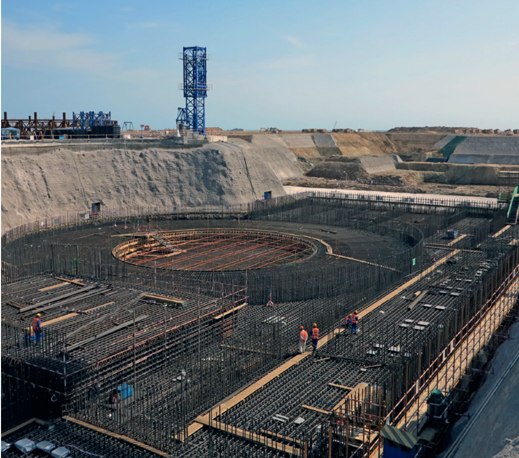
Central nuclear en construcción en China.
