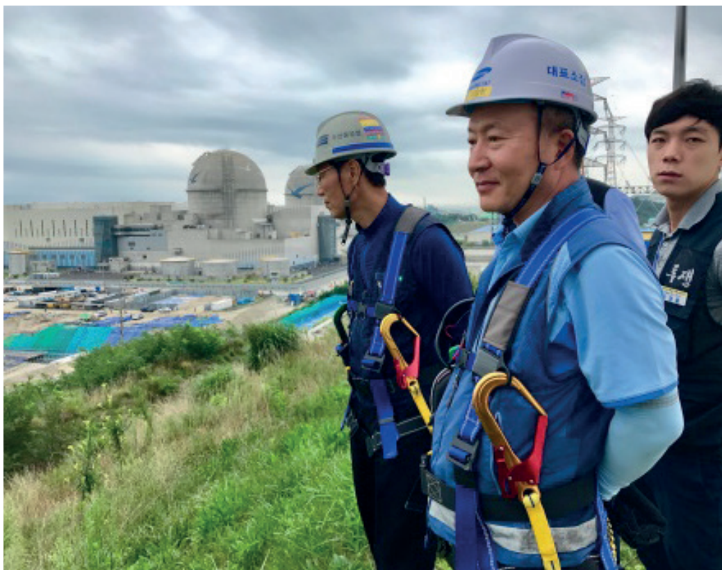
Опытные руководители наблюдают за строительством многоблочной атомной электростанции "Син Кори".
