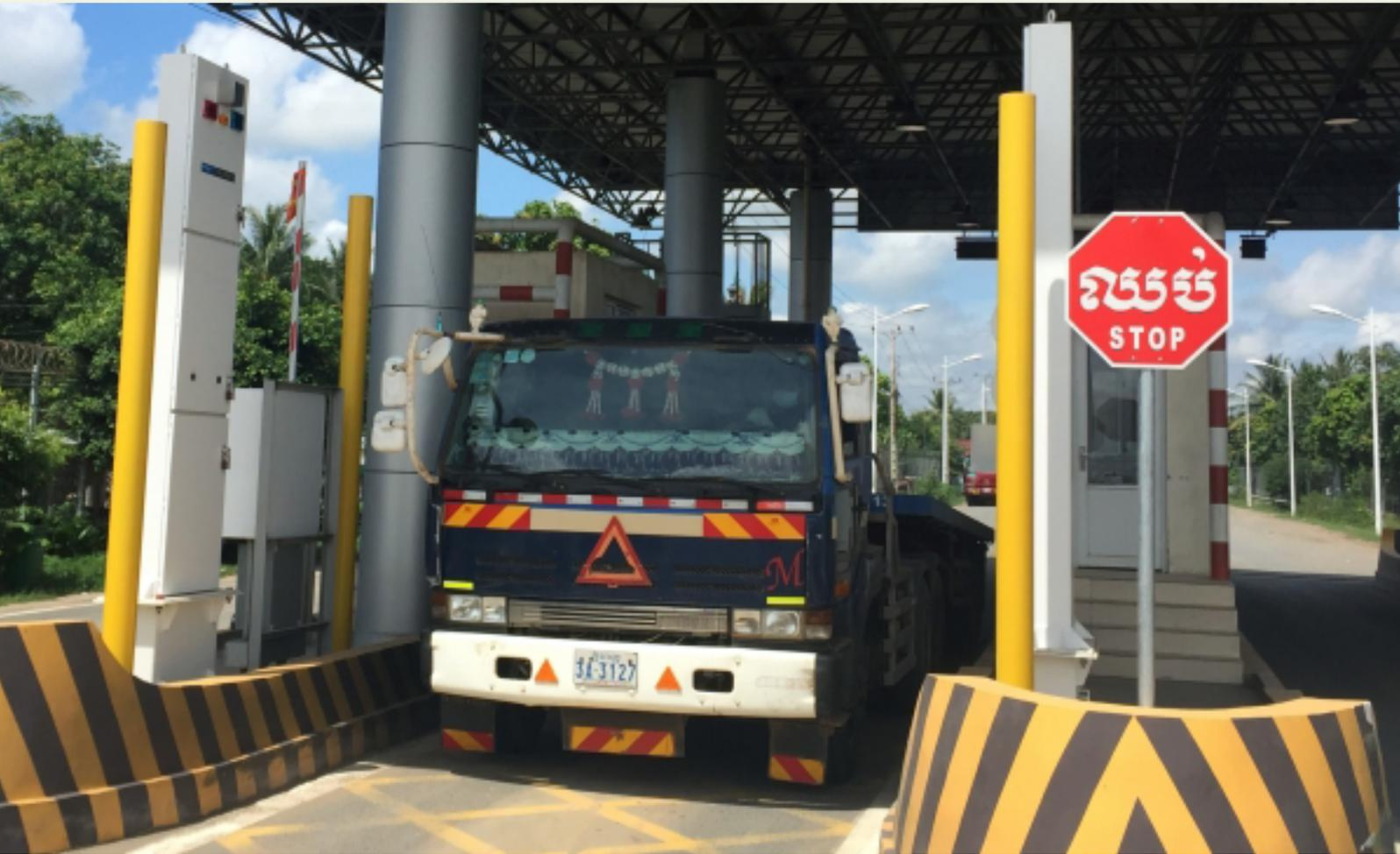
出入柬埔寨港口的每辆卡车都要经过一个门式辐射探测器——即带有红色、橙色和蓝色按钮的白色面板。金边港口三分之一的货物发出报警，即使它们只含有无害数量的天然辐射。国际原子能机构开发的一款新应用程序将帮助海关官员放大可能真正包含走私放射性物质的货物。
