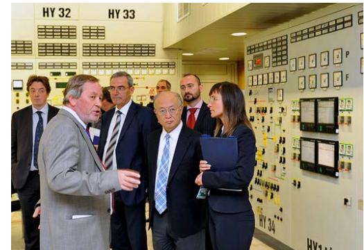
(الصورة من: محطة كوزلودوي للقوى النووية)
