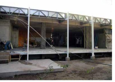
3 部分建筑被拆除,以建设可支撑新的热室重量的新墙体和楼板钢筋。已雇用了一家专业公司建设混凝土支柱。该期施工还包括组装铅砖支撑结构。
