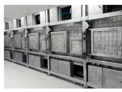
6 铅墙和铅门已装好,以确保该实验室的"热区"(放 射性材料存在的区域)是安全和安保的。"热区"还 是送入未加工放射性材料和送出经热室处理后的成 品(即放射性药物)的区域。
