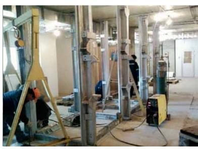
4 热室支撑结构由焊接和栓接在一起并固定在地面的钢板制成。热室的内外墙壁由铅砖构成。铅是建设热室的首选材料,因为铅的密度高,能阻挡有害辐射。
