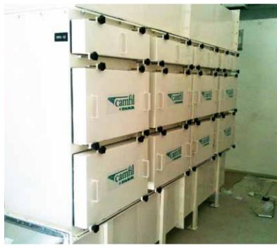
新的热室安装了有前置过滤器、高效粒子空气 (HEPA) 过滤器和活性炭过滤器的先进通风系 统,并设计了双过滤器系统,以提高安全性。
