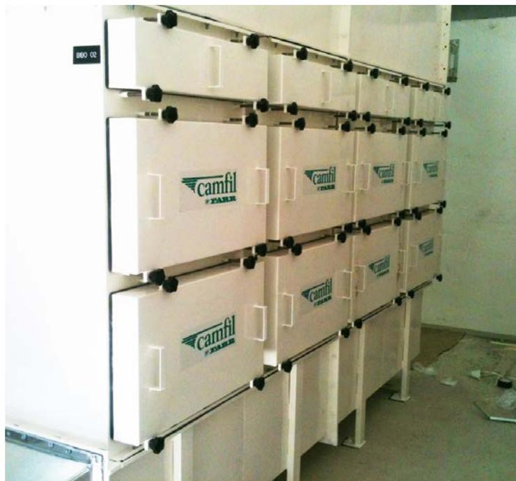
**8** Con las nuevas celdas calientes se instaló un sofisticado sistema de ventilación con prefiltrado, filtros de alta eficiencia (HEPA) y filtros de carbón activo, diseñado con un sistema de doble filtro para aumentar la seguridad.
