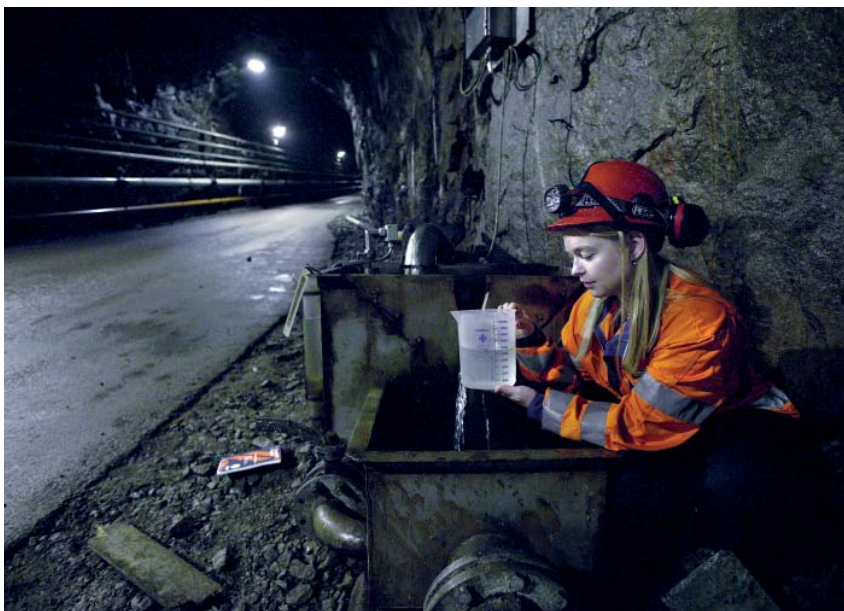
Строитель в подземном туннеле в Форсмарке, населенном пункте на восточном побережье Уппланда в Швеции.
