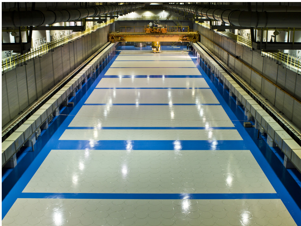
Intérieur d'un poste d'exploitation du Combinat chimique et minier. Le personnel supervise les assemblages de combustible nucléaire usé rechargés de manière automatique depuis l'installation d'entreposage en piscine vers l'installation d'entreposage à sec.
