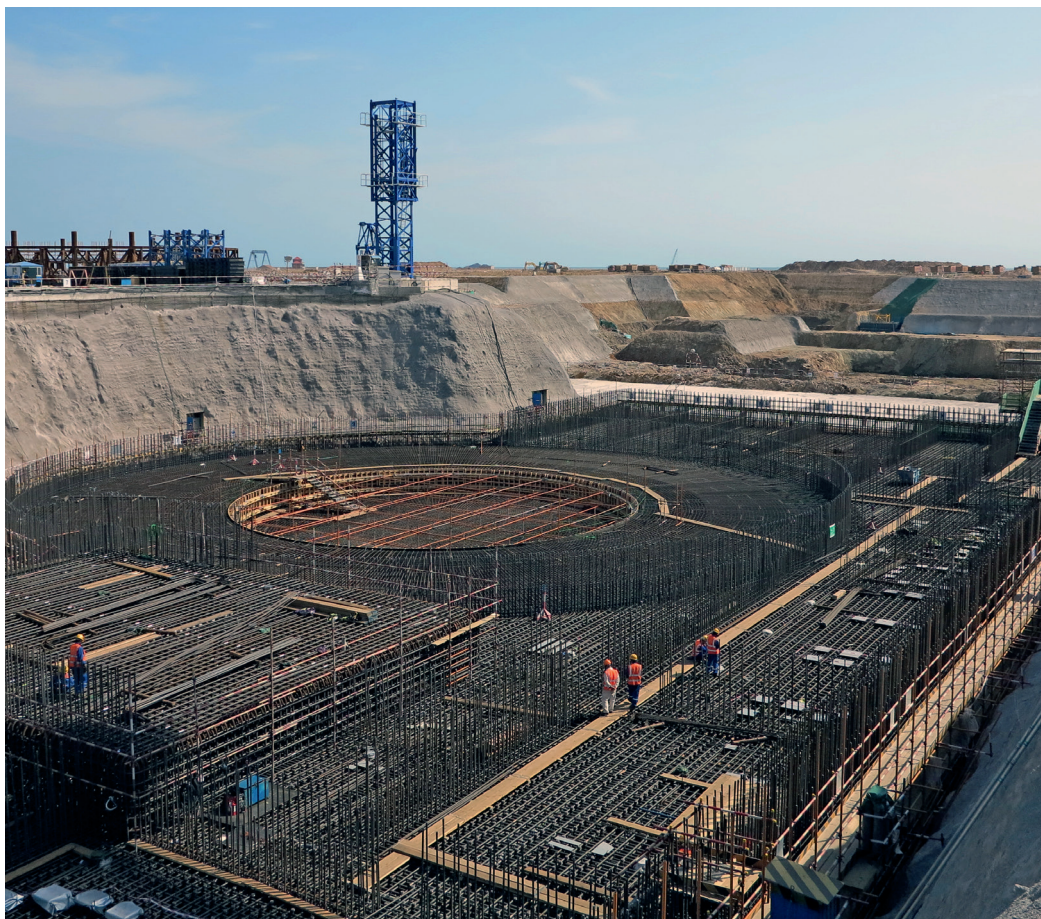
Centrale nucléaire en chantier en Chine.
