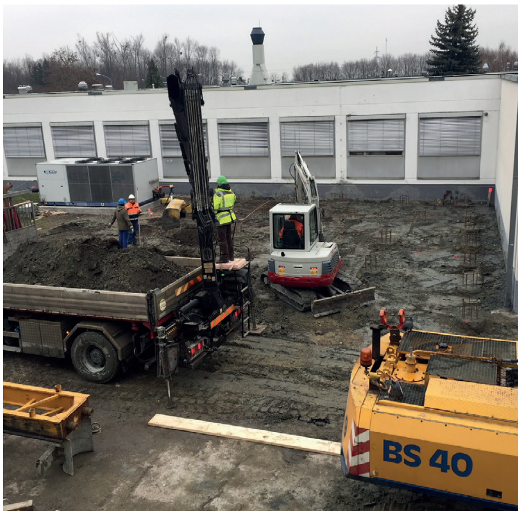
Строительство бункера для линейного ускорителя в комплексе МАГАТЭ в Зайберсдорфе, Австрия.
