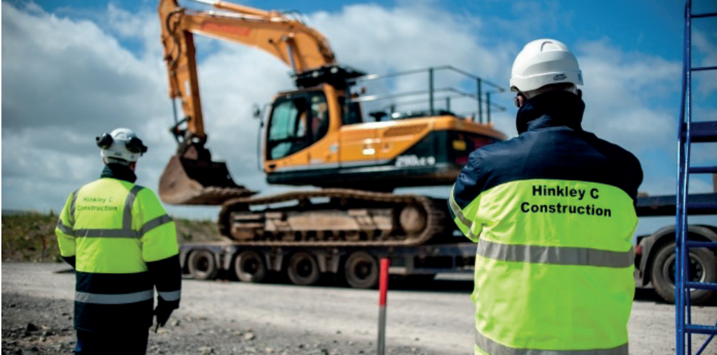
Trabajadores en las obras de construcción de Hinkley Point C
