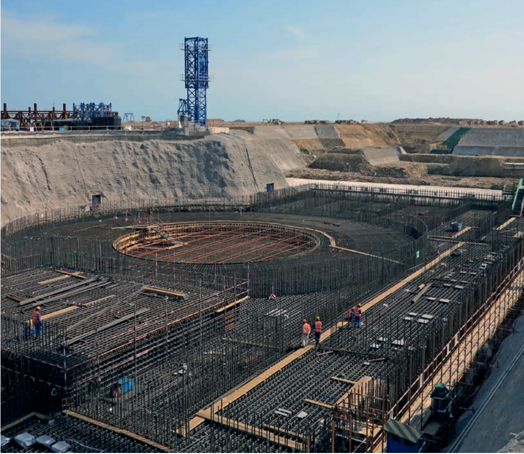
محطة قوى نووية قيد التشييد في الصين.
