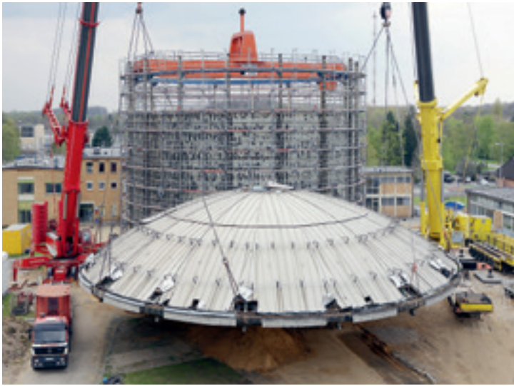
Déclassement du réacteur de recherche MERLIN, en Allemagne, en 2008.
