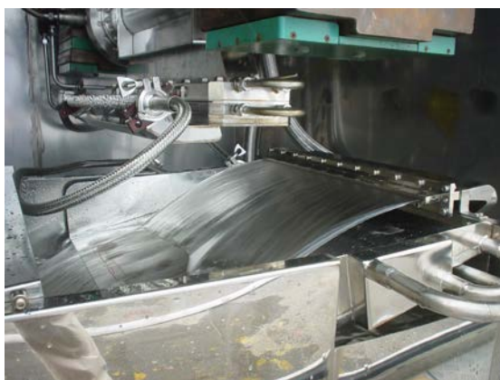
FIG. 2. Traitement des eaux usées industrielles par faisceaux d'électrons pour assainissement avant évacuation. (Crédit photo : EBTech.)
