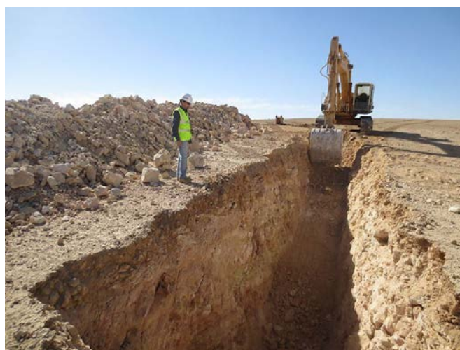
FIG. 1. Excavation d'une tranchée pour évaluation dans un gisement d'uranium dans le centre de la Jordanie.
