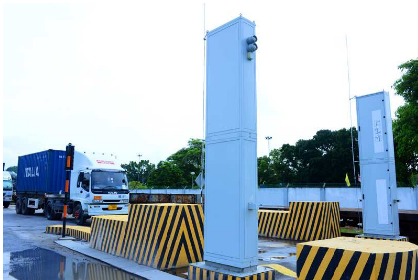
FIG. 1. Portique de détection des rayonnements à la frontière entre la Thaïlande et la Malaisie. Cet appareil détecte les rayonnements en temps réel sans interrompre les activités normales d'importation et d'exportation.
