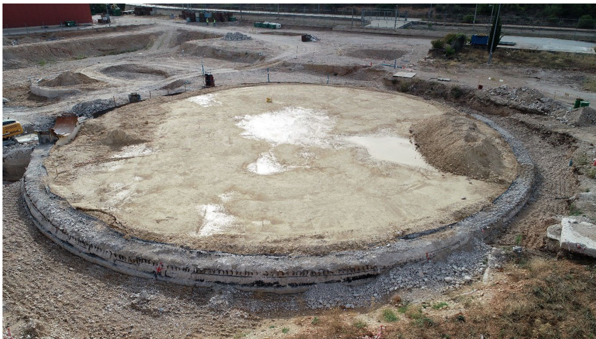
Рис. С.1. Бывшее здание гермообъема АЭС «Хосе Кабрера» (источник: «Энреса»).
