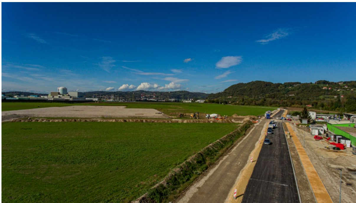
РИС. С.8. Подготовка площадки для строительства пункта захоронения эксплуатационных отходов АЭС в Словении (источник: АРАО).
