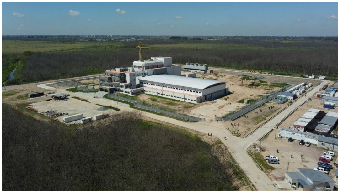
РИС. Е.1 а. Строительство исследовательского реактора RA-10 в Аргентине близится к завершению (источник: Национальная комиссия по атомной энергии Аргентины).
