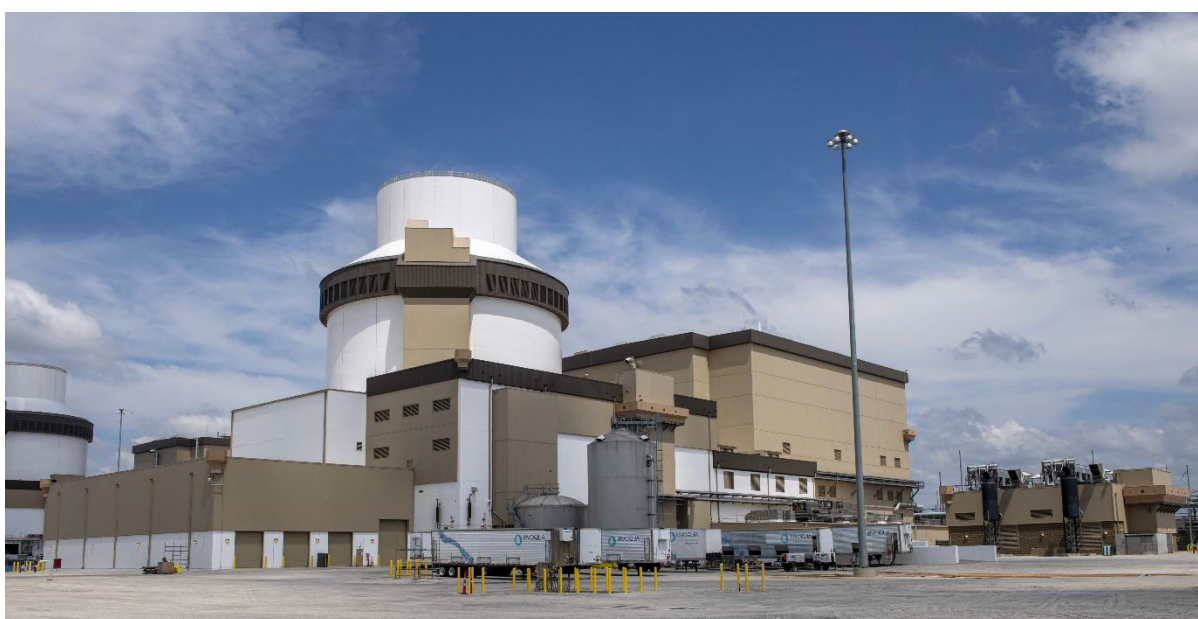
Рис. А.3. Блок № 3 электростанции «Вогтль», штат Джорджия, США, после завершения строительства (источник: компания «Саузерн ньюклар»).
