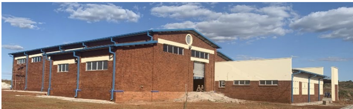
РИС. С.6. Недавно построенное централизованное предприятие по обращению с отходами в Зимбабве (источник: МАГАТЭ).
