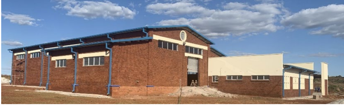
الشكل- جيم-5- المرفق المركزي لإدارة النفايات الذي شُيّد حديثاً في زمبابوي. (المصدر: الوكالة)
