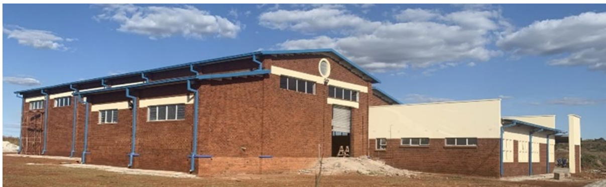
图 C.6. 津巴布韦新建的集中式废物管理设施。(照片来源：原子能机构)
