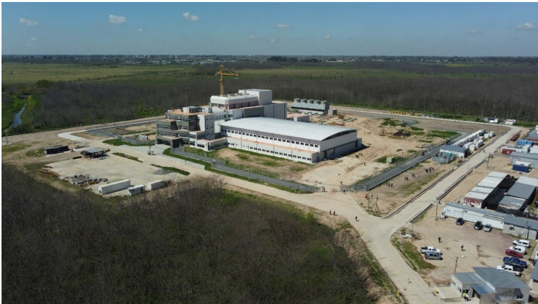
图 E.1 a. 阿根廷 RA-10 研究堆的建造已接近完工。 (照片来源：阿根廷国家原子能委员会)
