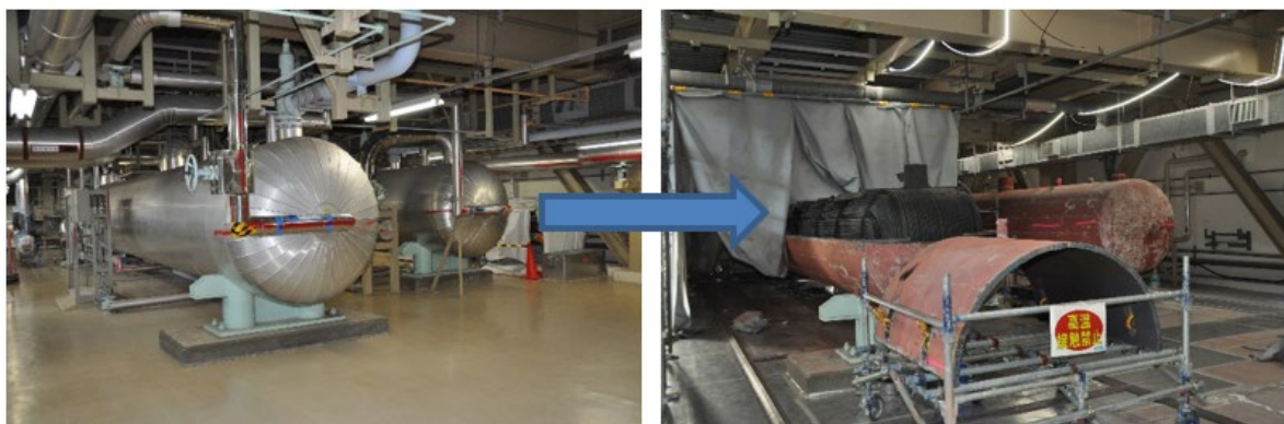
图 C.2. 作为文殊堆退役工作的一部分，拆除高压给水加热器。 (照片来源：日本原子力开发机构)
