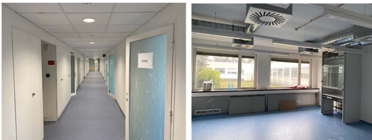
РИС. В.3. Ремонт Дозиметрической лаборатории, март 2024 года. (Источник: МАГАТЭ)
