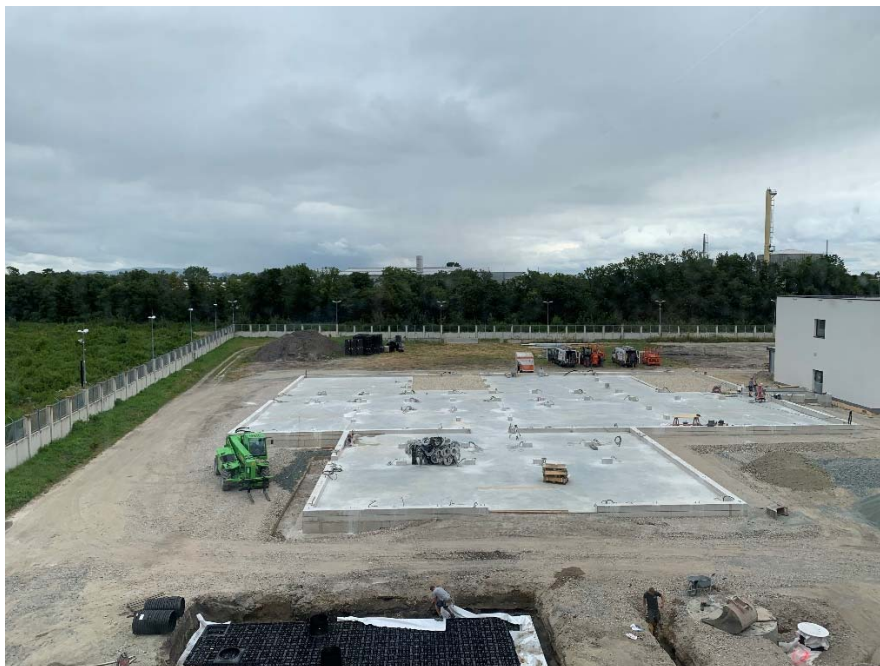
РИС. В.4. Готовый фундамент теплиц, июль 2024 года. (Источник: МАГАТЭ)
