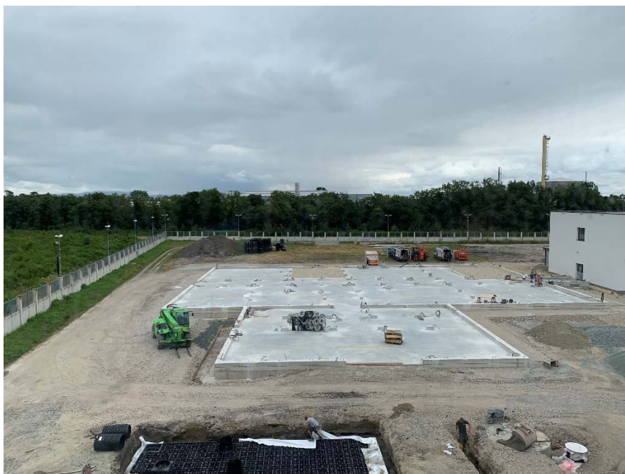
图 B.4. 温室地基完工，2024 年 7 月。（照片来源：原子能机构）
