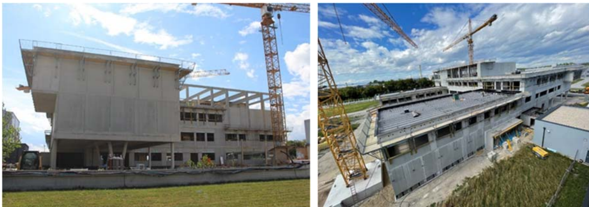
图 B.1. “移动模块式实验室 2”外墙和屋顶隔热工程，2023 年 9 月。
