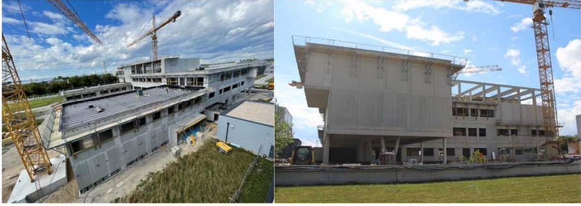
الشكل باء-1- أعمال الواجهة وعزل الأسقف في المبنى FML2، أيلول/سبتمبر 2023. (المصدر: الوكالة الدولية للطاقة الذرية)
