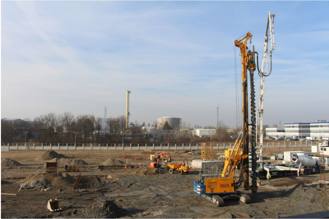
الشكل باء-2- حالة تشييد مبنى المختبرات الجديد وأساسات الدفيئات اعتباراً من شباط/فبراير 2023. (المصدر: الوكالة)
