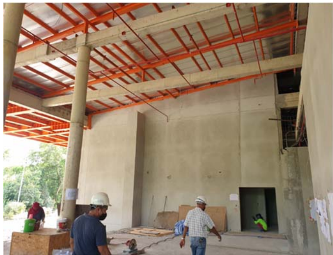
正在进行的回旋加速器综合大楼的施工工作。（照片来源：Kanokporn Boonsirichai 博士，泰国核技术研究所）
