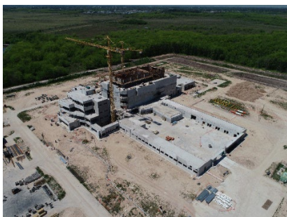
FIG. D-1 a. Construction d'un réacteur de recherche RA-10 au Centre atomique Ezeiza en Argentine. (Photo : CNEA)
