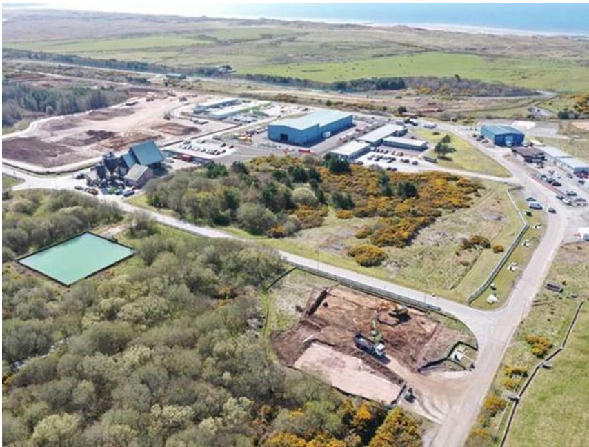
FIG. C-3. Travaux préparatoires de mise en place d'une couverture définitive sur une partie du dépôt de déchets de faible activité (Royaume-Uni). (Photo : Autorité du déclassé nucléaire du Royaume-Uni, 2021)
