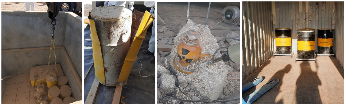
FIG. C-4. Retrait et reconditionnement de sources radioactives dans de nouveaux colis sur un ancien site d'entreposage de déchets en Jordanie. (Photos : Commission jordanienne de l'énergie atomique)
