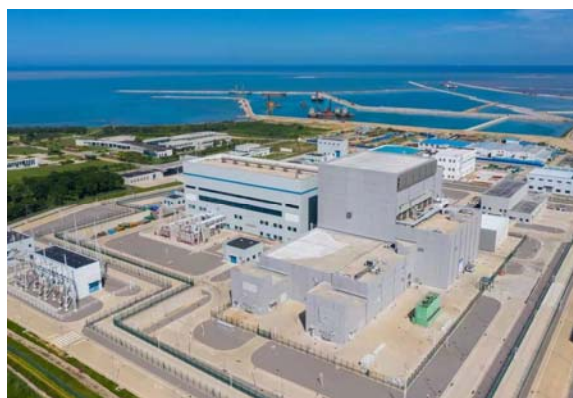
Первый энергоблок с реактором НТР-РМ на АЭС «Шидаовань», Китай (Фото: НКАЭ)
