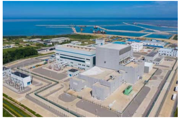
中国石岛湾核电站首座球床模块式高温气冷堆 (照片来源：中国核能行业协会)
