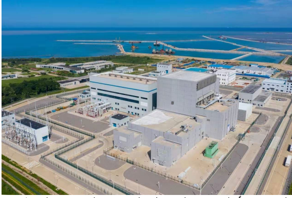
الوحدة الأولى من المفاعل المرتفع الحرارة النمطي الحصوي القاع- في محطة خليج شيذاو للقوى النووية، الصين. (الصورة من: الهيئة الوطنية للطاقة الذرية الأرجنتينية)
