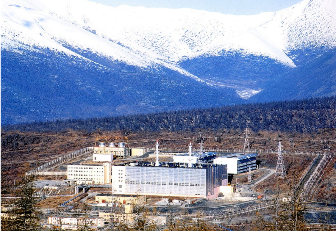
الشكل-ألف-٤- محطة بيليبينو للقوى النووية، التي تُستخدم في التوليد المشترك للحرارة والكهرباء في الاتحاد الروسي (الصورة من: هيئة روزاينيرغواتوم "ROSENERGOATOM")
