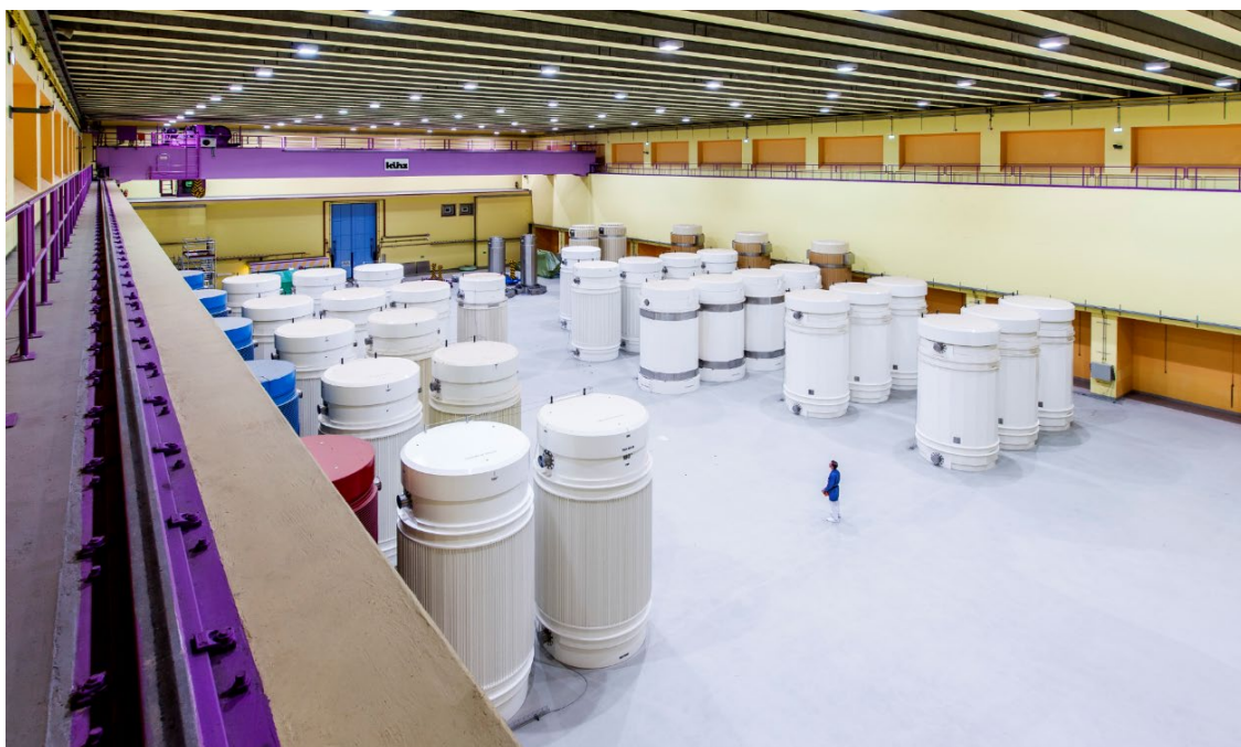
الشكل-جيم-٥- تُستخدم قاعة خزن البراميل في مرفق تسفيلاغ في سويسرا لتخزين النفايات القوية الإشعاع المزججة الناشئة من محطات إعادة المعالجة ومكونات الوقود المستهلك الناشئة من محطات القوى النووية السويسرية. (الصورة من: مرفق تسفيلاغ)
