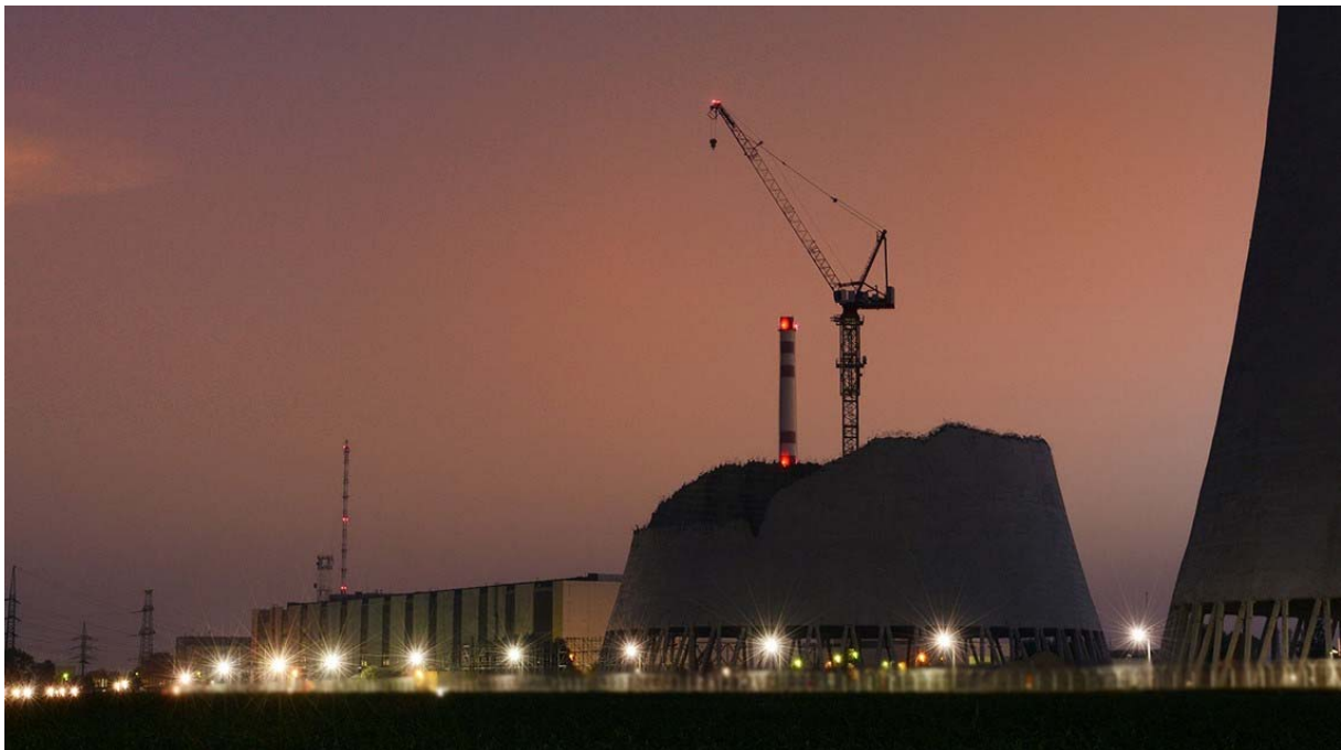
图 B.2. 拆除斯洛伐克 V1 核电站冷却塔。（照片来源：JAVYS, a.s.）
