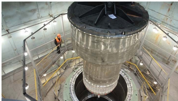
Fig. B-4. Instalación del MBIR.
