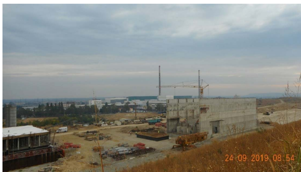
Fig. A-17. Construcción de la NDF en el emplazamiento de Radiana, cerca de la central nuclear de Kozloduy; la imagen muestra una parte del complejo administrativo (izquierda), el edificio de recepción de desechos y almacenamiento intermedio (derecha) y los cimientos de cemento-loess de la Plataforma de Disposición Final 1 (extrema derecha).
