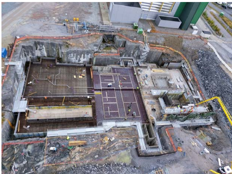
Fig. A-16. Construcción de la planta de encapsulamiento de combustible nuclear gastado de Posiva. (Fotografía: Posiva)
