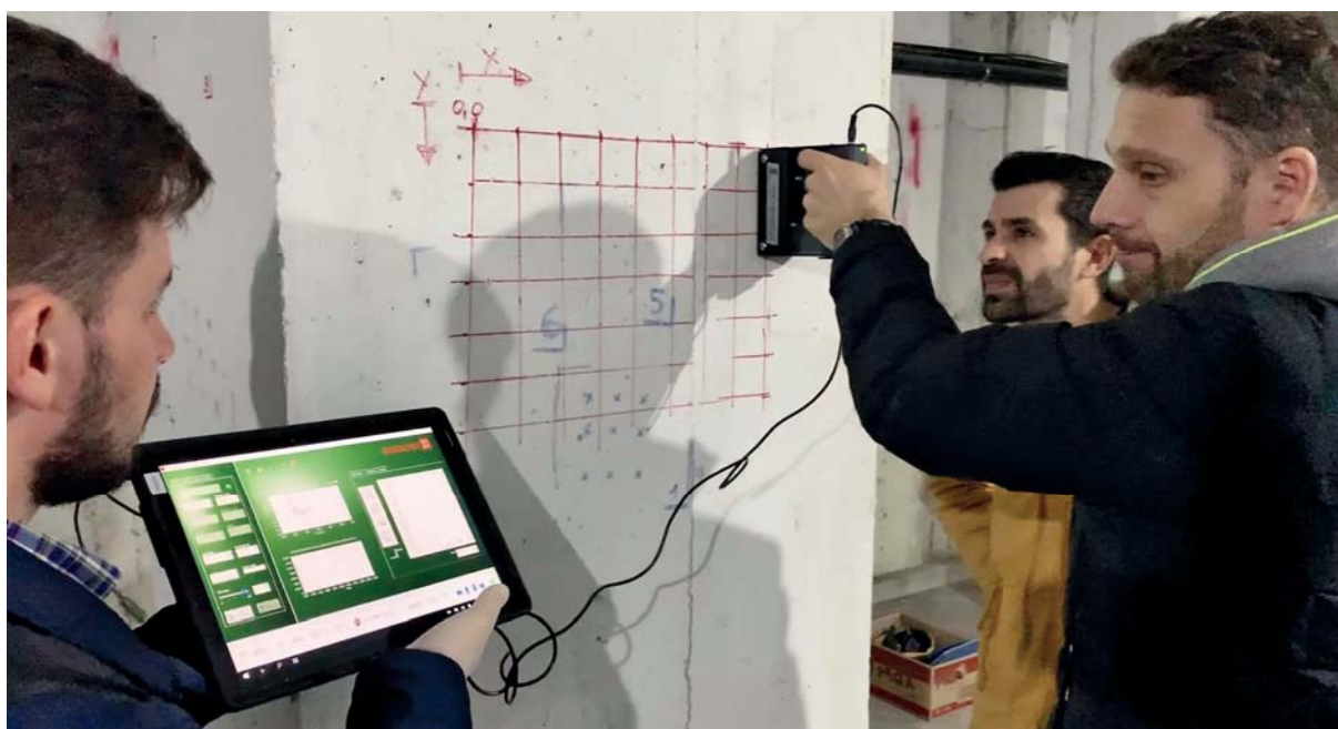
Fig. 1. Inspección de estructuras en Albania mediante equipo de END.
