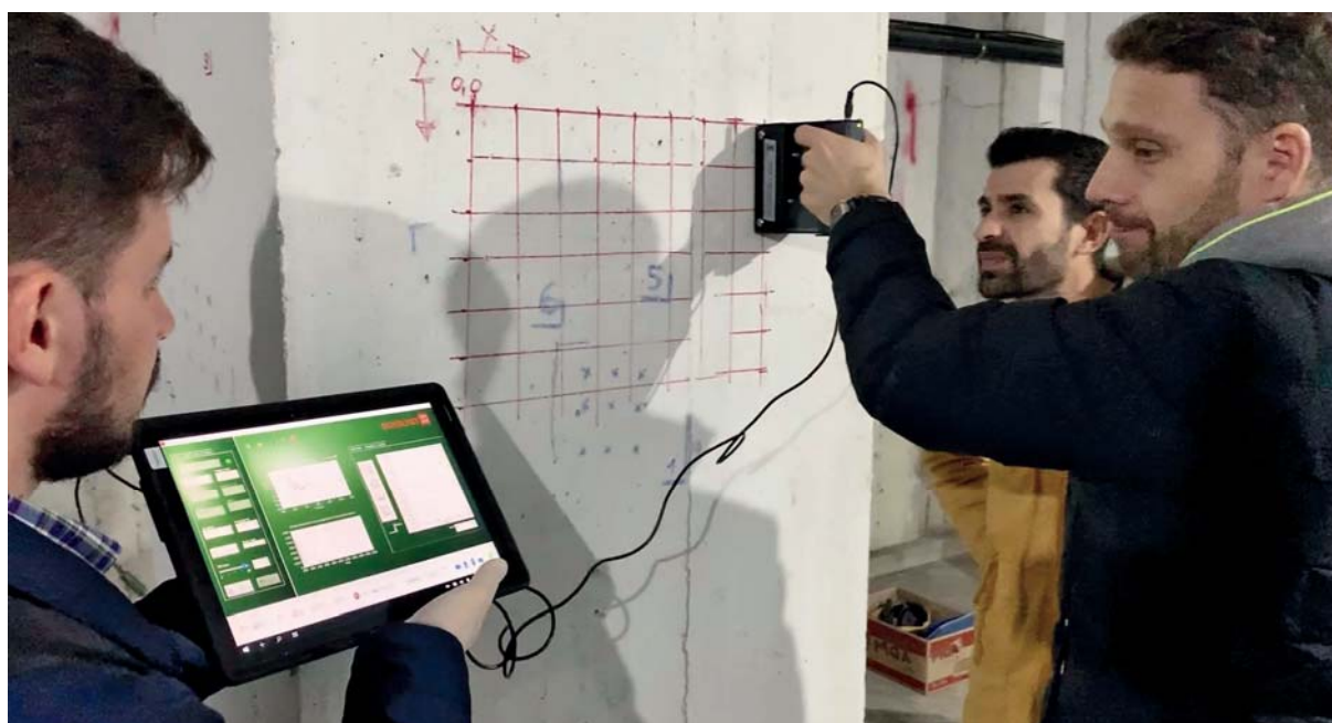
FIG. 1. Inspection de structures en Albanie à l'aide de matériel d'END.
