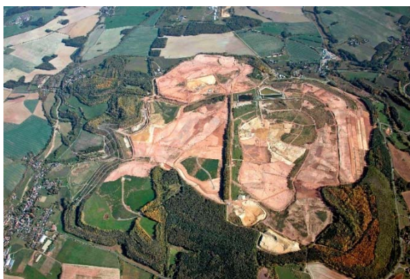
FIG. A-5 Bassin de retenue de résidus de Culmützsch en cours de remédiation (Allemagne), 2018. (Photo : Wismut GmbH)
