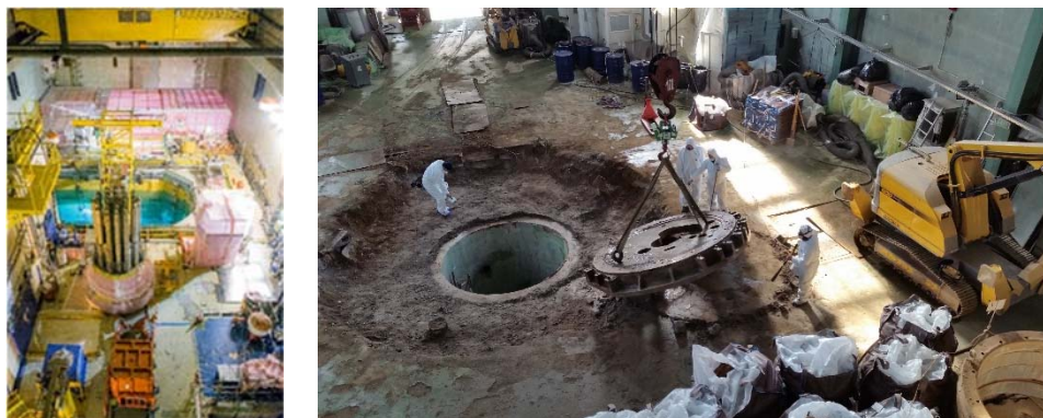
图 A-4. 拆除法国舒兹 A 核动力堆部件（左），以及罗马尼亚默古雷莱研究堆的退役进展（右）。（照片来源：法国电力公司、原子能机构）
