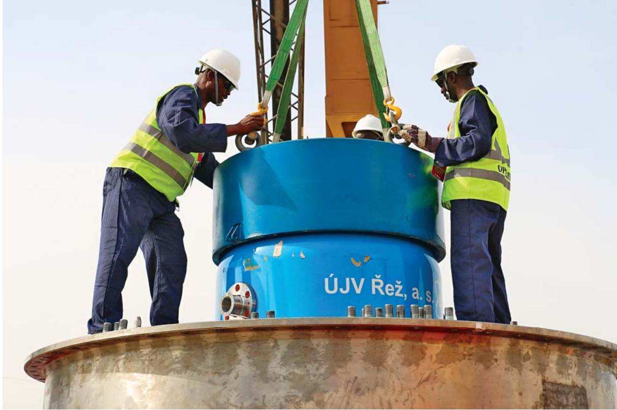
الشكل ٢ - عمال يُحمّلون وقود اليورانيوم الشديد الإثراء في حاوية لنقله من نيجيريا إلى الصين في كانون الأول/ديسمبر.
