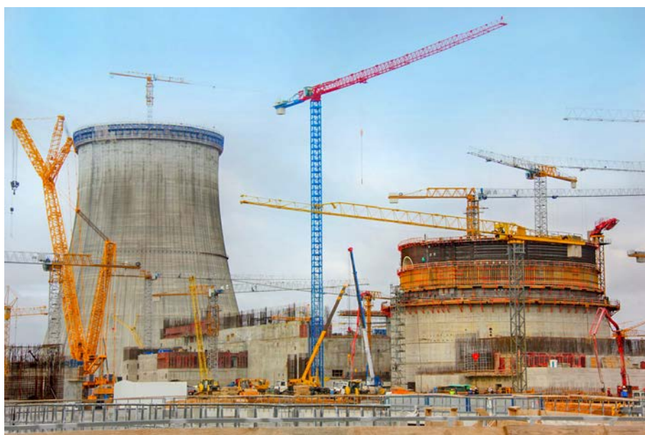
Fig. 1. Obras de construcción de las unidades 1 y 2 de la central nuclear de Ostrovets en Belarús (Fotografía por cortesía de la Dirección para la Construcción de Centrales Nucleares de Belarús).
