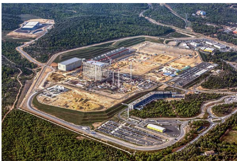
Fig. 3. Vista aérea del emplazamiento del ITER en septiembre de 2015.
