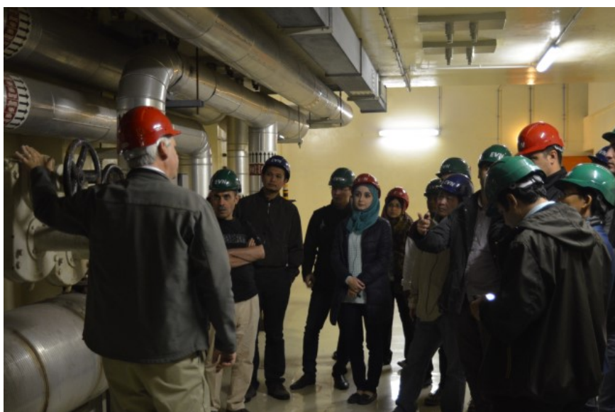
FIG. 1. Participants à une des deux visites d'inspection visuelle de la centrale nucléaire autrichienne de Zwentendorf, jamais mise en service, dans le cadre de la formation dispensée par l'Agence en 2015.
