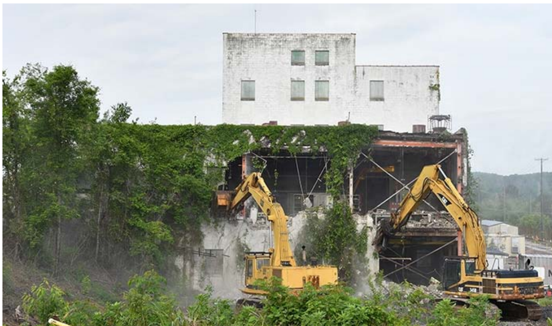
Fig. C-3. Avances en las obras de rehabilitación del antiguo emplazamiento de la Planta de Difusión Gaseosa de Oak Ridge, en Tennessee (Estados Unidos de América). (Fotografía: Departamento de Energía, Estados Unidos de América)
