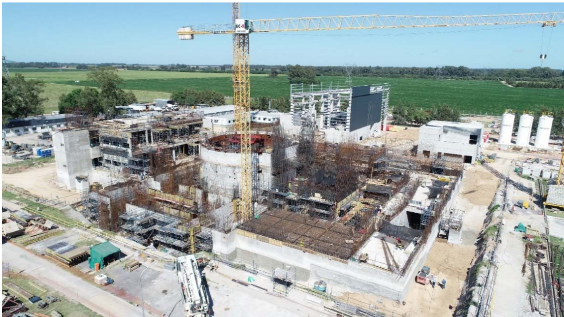
Fig. A-2. La construcción del CAREM en un emplazamiento adyacente a la central nuclear Atucha II/Néstor Carlos Kirchner de la Argentina está en una etapa avanzada, y en 2024 comenzará la explotación con vistas a producir 30 MW(e) como demostración del prototipo. (Fotografía: CNEA)
