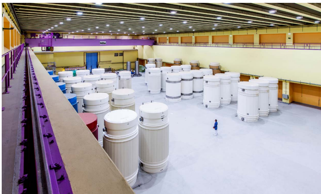
Fig. C-5. Sala de almacenamiento de cofres de ZWILAG, en Suiza, utilizada para almacenar los desechos vitrificados de actividad alta de las plantas de reprocesamiento y los elementos combustibles gastados de las centrales nucleares suizas. (Fotografía: ZWILAG)
