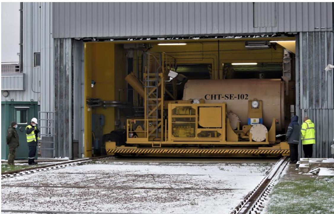
Fig. C-1. El primer contenedor blindado de doble pared, cargado con 93 conjuntos combustibles gastados, abandona la instalación de procesamiento del combustible gastado con destino al lugar de almacenamiento por 100 años.
